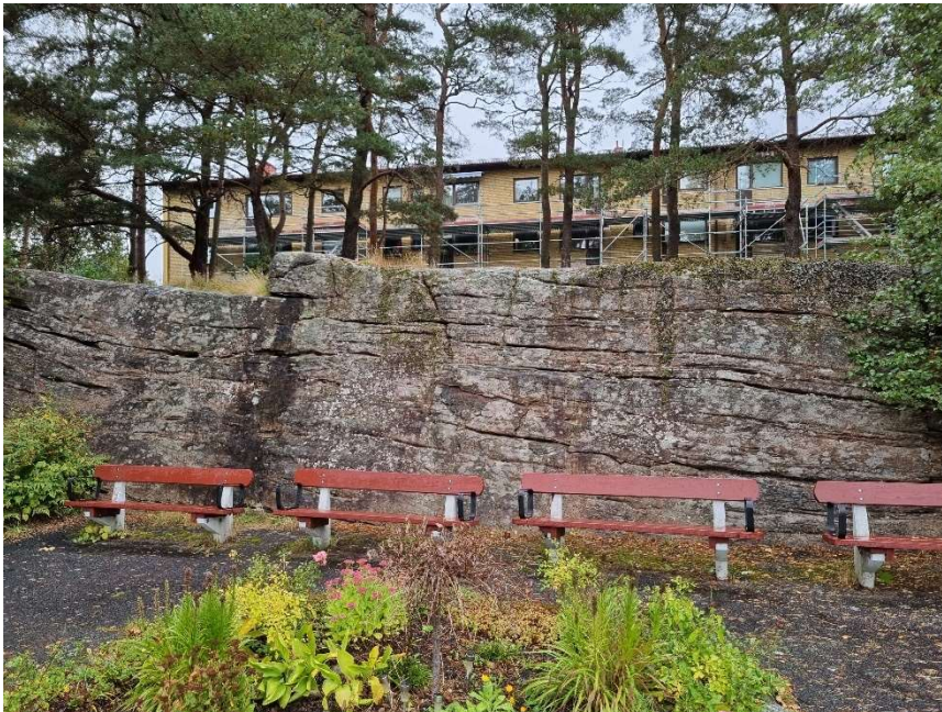
Figur 16. Foto av bergsskäring i område B, taget mot norr.
