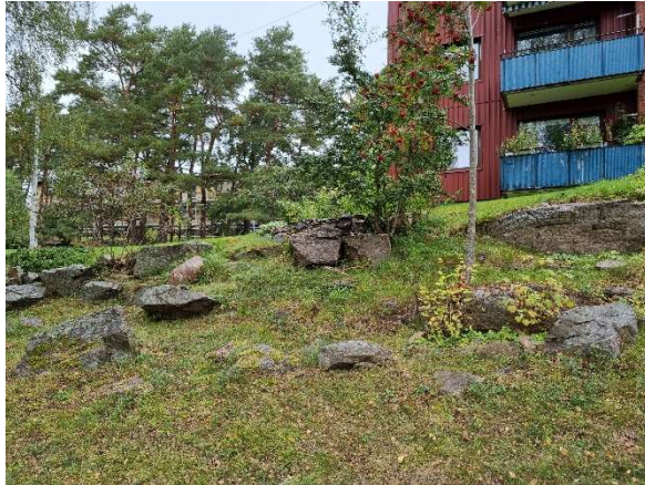
Figur 15. T.v Foto av bergsskäring och block i jordslänt taget mot norr från GC-väg. Blocken på bild bedöms inte utgöra någon risk. T.h Foto på potentiellt löst block i Område A, taget mot norr.
