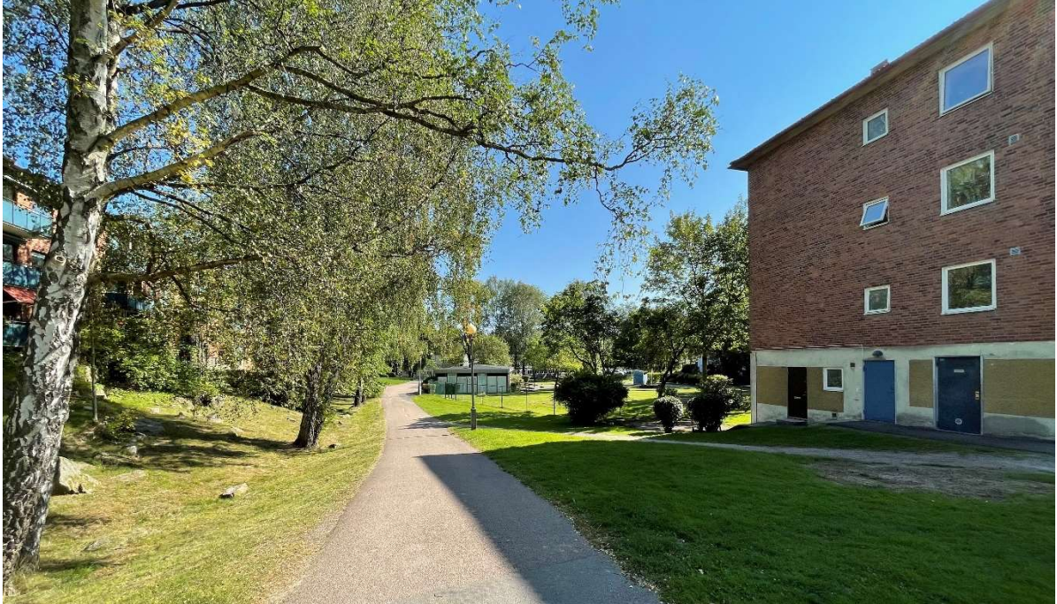
Figur 4. Foto över norra och nordöstra delen av området. Fastighet SÄVENÄS 111:1 till vänster och Fastighet SÄVENÄS 112:1 till höger. Foto tagen på plats 2021-09-02
